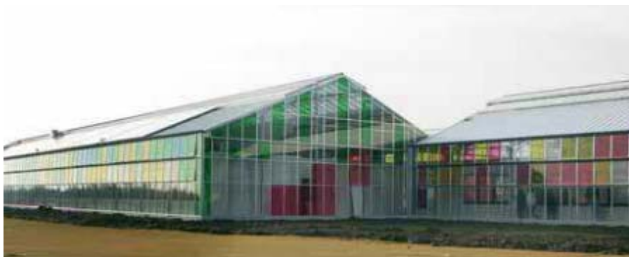
Le nouveau bâtiment Innovation au Biopôle livré en janvier (Pictural)
